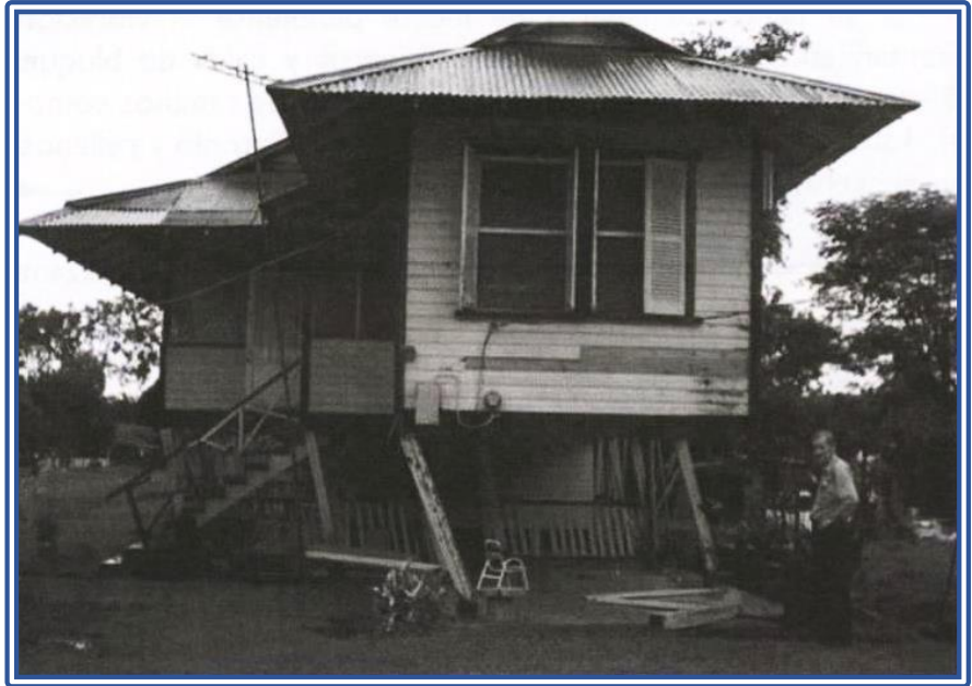
Fig. 7. Colapso parcial de vivienda en Finca Damas. Fuente: Red Sismológica Nacional
