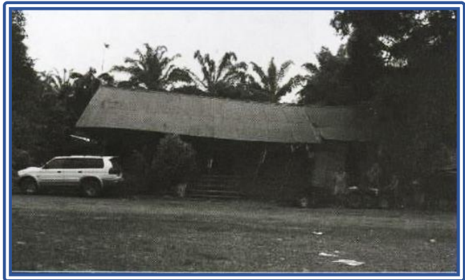
Fig. 6. Colapso del Comisionato en El Tigre de Parrita. Fuente: CNE.
